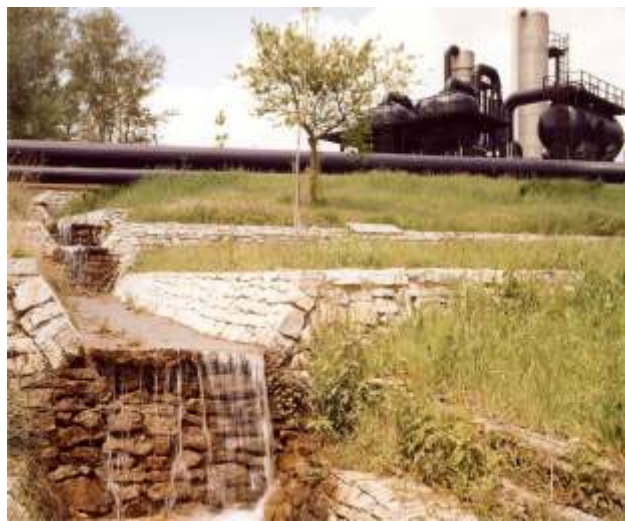
Centrale geotermica Bagno 3. Sistemazione ambientale e paesaggistica: in primo piano, l'impluvio per la raccolta delle acque provenienti dai drenaggi profondi. Foto di Alessandro Cimmino.
