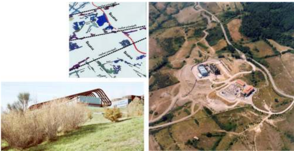
Centrale geotermica Bagnore 3. Reinterpretazione dei rapporti tra la nuova centrale e le trame paesistiche e ambientali del monte Amiata: riconoscimento elementi del paesaggio vegetale (siepi, filari, macchie boscate).
